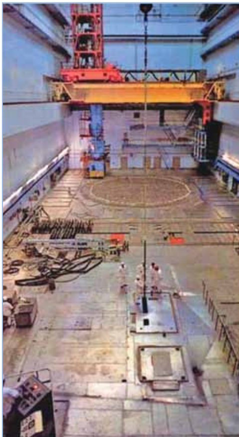
Реакторный зал установки РБМК-1000
