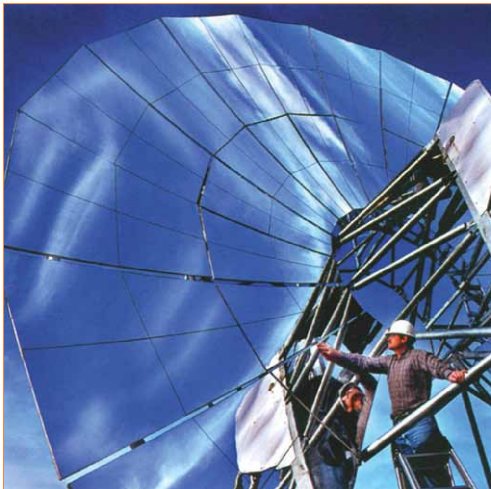
Монтаж солнечных батарей
