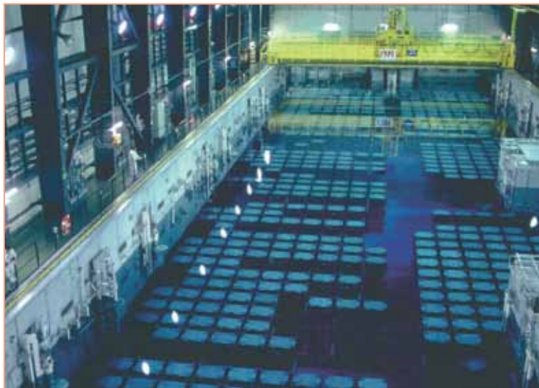
Бассейн для хранения отработанного ядерного топлива
