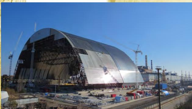
К концу 2016 года над 4-м энергоблоком ЧАЭС и накрывавшим его саркофагом, который к тому времени уже начал разрушаться, было возведено новое защитное арочное сооружение. Монтировали арку на расстоянии 250 метров от разрушенного реактора, и только потом по специально проложенным рельсам надвинули на аварийный энергоблок.
