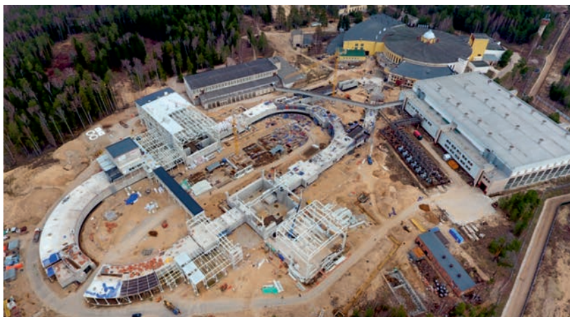
Рис. 7.25. Строительная площадка комплекса NICA (осень 2019 г.)
