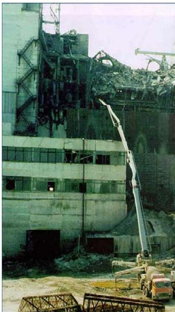
Рис.53 Дистанционная подача бетона
